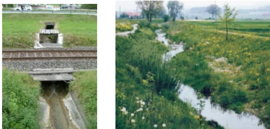
FIGURE 15 : A GAUCHE: SITUATION ACTUELLE DU RUISSEAU AU PASSAGE DE LA VOIE CFF A DROITE: EXTRAIT DE LA DIRECTIVE: ESPACE POUR LES COURS D'EAUX, PARTIE 1 OFEG, BERNE 2000
